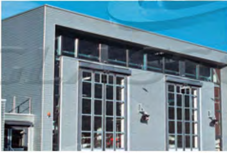
DB Triebzuganlage, Berlin (D)
